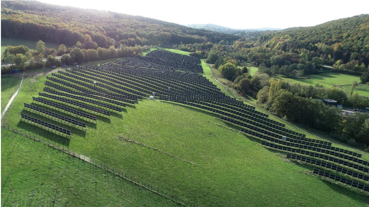
Bildunterschrift: Solarpark in Eppelborn Deutschland (2 MWp)
